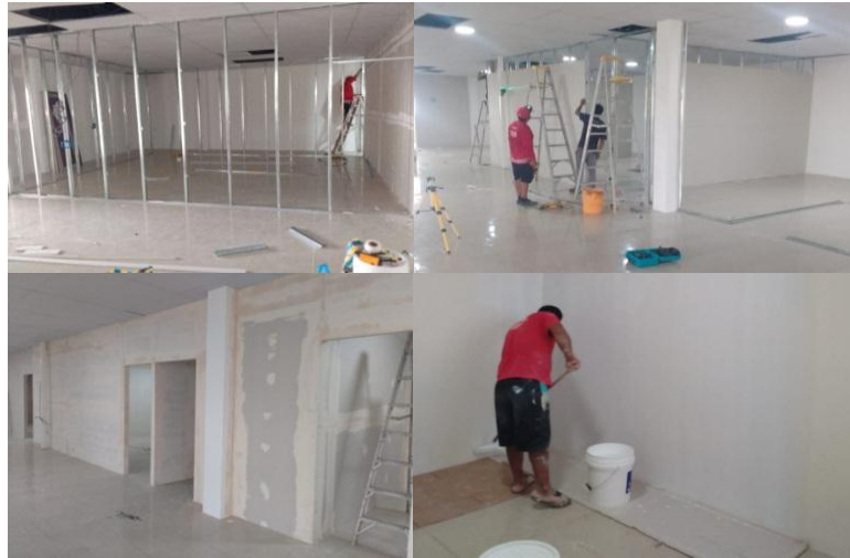
Ilustración 1: Trabajos realizados –adecuaciones de las nuevas instalaciones
